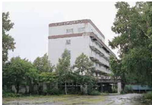
解体予定の川湯プリンスホテル
