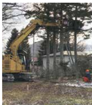
丁寧な作業で危険木を撤去
