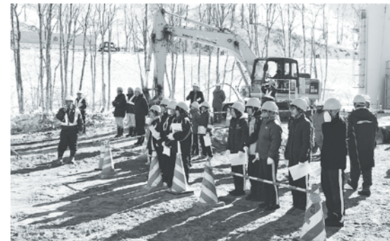
工事の様子に見入る生徒
