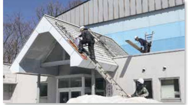
尙小野寺塗装店(小野寺一史代表取締役)の皆さんが、4月5日に美留和小学校屋体の入口の屋根の塗装を行いました。地域の皆さんや子供たちが気持ちよく利用できるようにと行われたもので、3人が参加。塗装を終えた屋根は見違えるようになっています。
