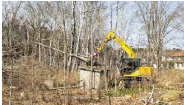
今井林業株(西村良雄代表取締役)の皆さんが4月26日、川湯地区の町有地内で倒木の危険がある木の伐採を行いました。倒木による被害が発生する前に伐採しようと、作業には2人が参加。重機などを使い丁寧に作業を行いました。西村社長は、「被害が発生する前に伐採できてよかった」と話していました。
