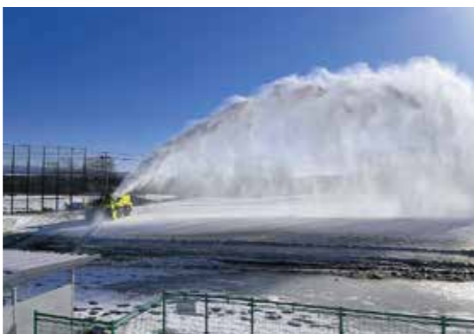
重機を使った作業
