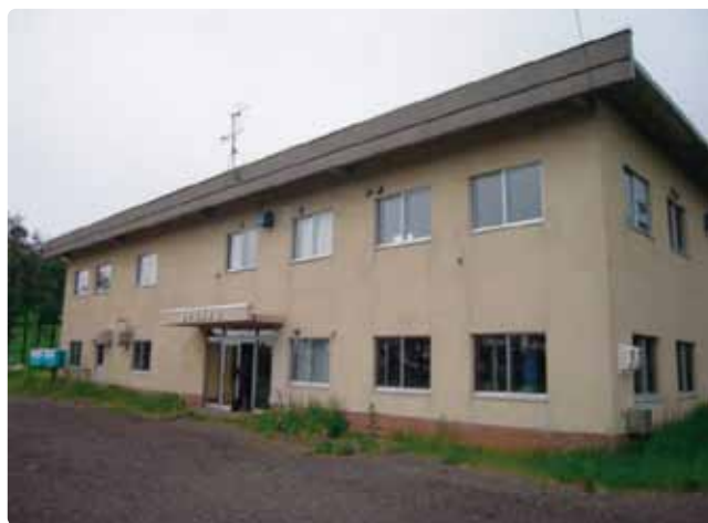
弟子屈浄水場
