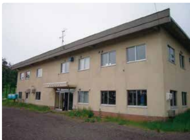
弟子屈浄水場
