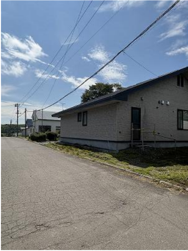
外見北東面裏側
