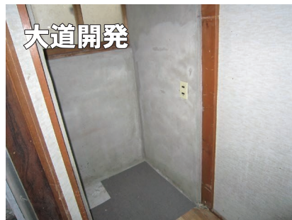
▲浴室横スペース
