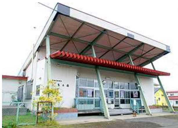
■町営公衆浴場「泉の湯」(外観)
