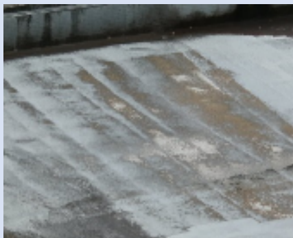
屋上防水(エントランス上部)
