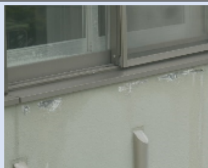
外壁(校舎北面)
