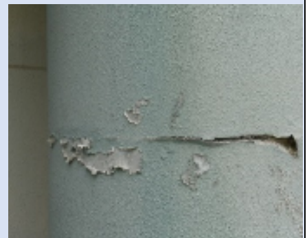
屋外柱(校舎1階南西角)
