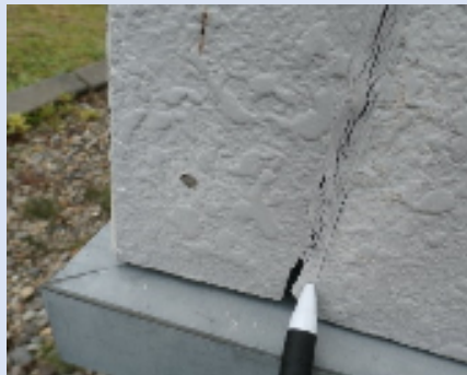
外壁(シーリング)
