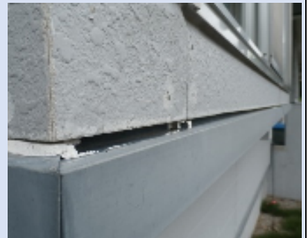
外壁(シーリング)
