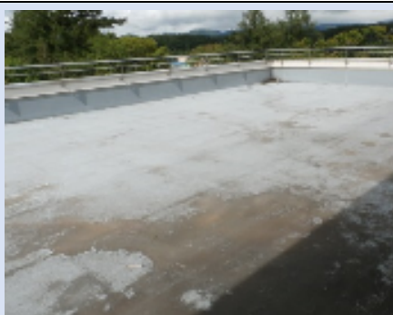
屋上防水(玄関上部)
