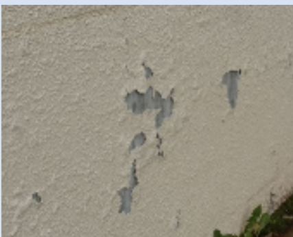
外壁(普通教室棟裏)
