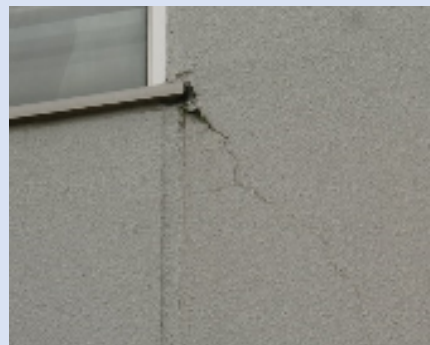
外壁(校舎北面)
