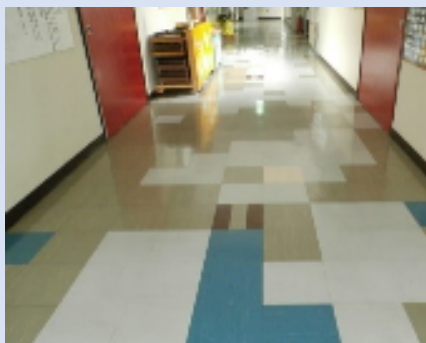
廊下(部分張替後のPタイル)
