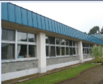
屋根外壁(校舎)
