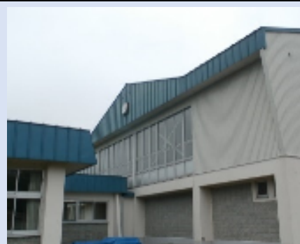
屋根外壁(体育館)
