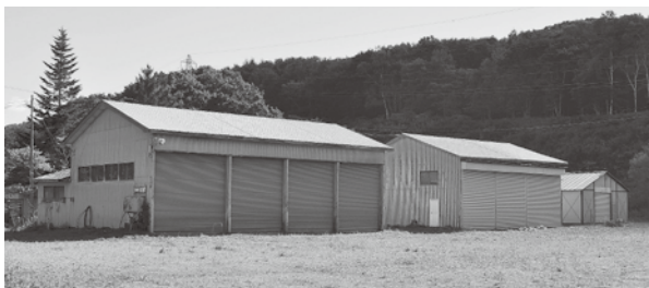
除雪用建設機械を保管している車庫
