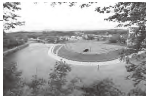
護岸工事の終わった釧路川(旧国立病院跡地付近)
