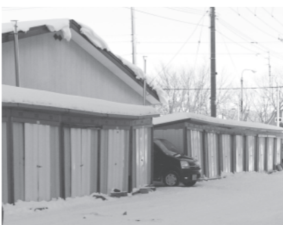
老朽化の進む公営住宅の物置
