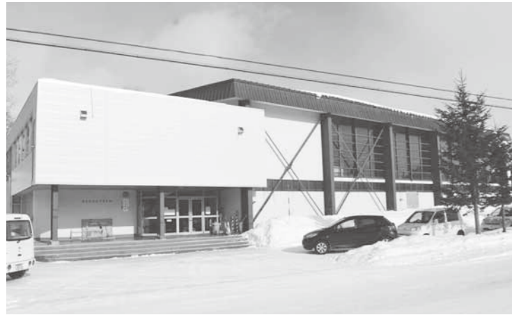
改修された川湯青少年開館
