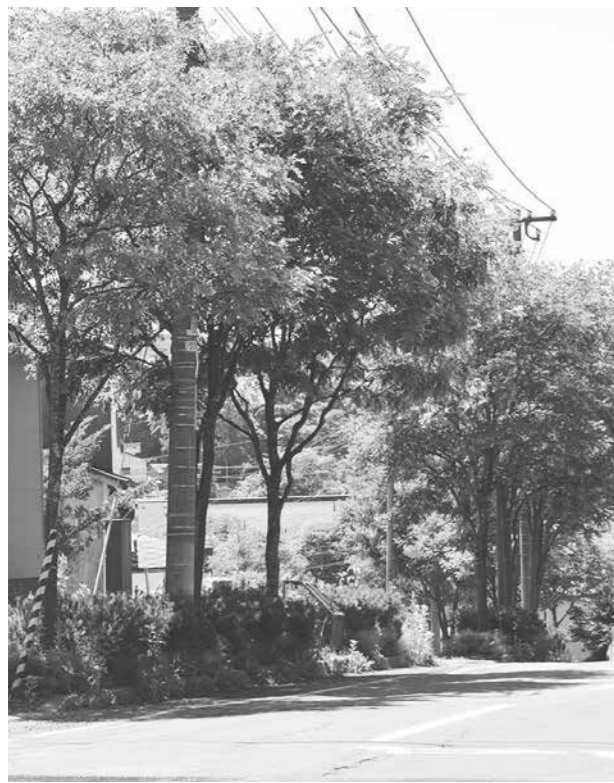
通学などの支障になっている植栽ますを改修
