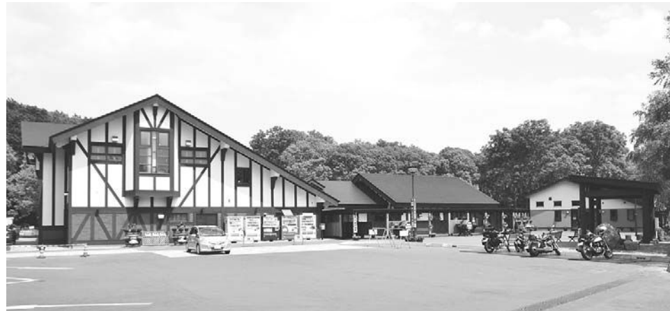
道の駅に多世代交流の場を設けては
