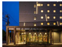
2022年竣工 小樽市 グリフズプレミアムホテル小樽
