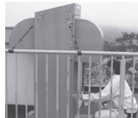
(写真1) 摩周湖に設置された霧水捕集装置
