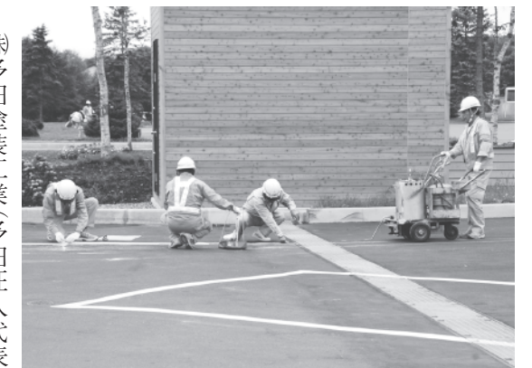
多田塗装工業による駐車場のライン引き
