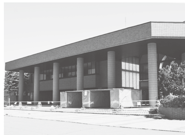
外壁を改修中の摩周観光文化センター
