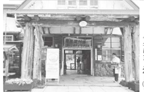
川湯駅のエコパスステーション
