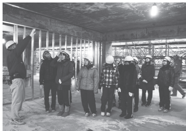
コンクリート打ちっ放しの現場を見学
