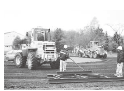
東星波部建設のグラウンド整備
