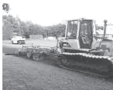
今道東建設工業による美小グラウンド整備
