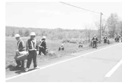
今道東建設工業による道路の清掃
