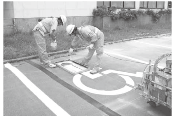
多田塗装工業の皆さんによる林業多目的センターの駐車場ライン引き
