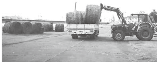
川路事務所では、釧路川の堤防保護と河川環境保全を目的に、堤防除草工事を実施
