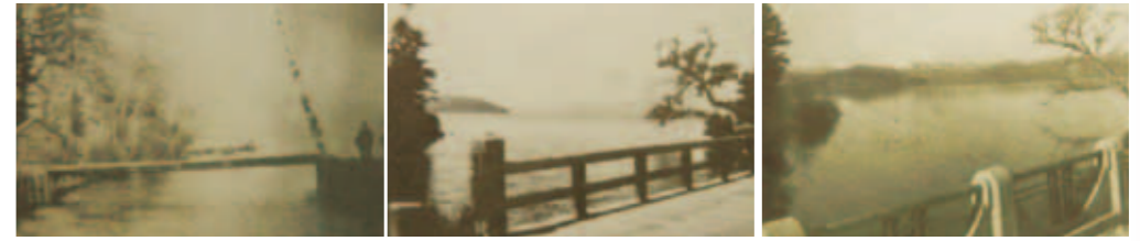
二代目木橋 三代目木橋 六代目コンクリート橋
