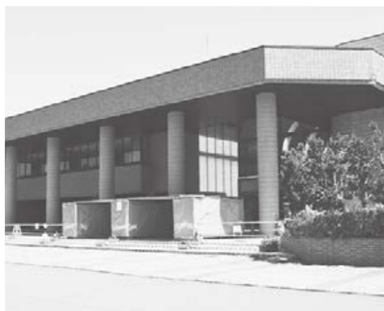
現在、外壁を改修中の摩周観光文化センター
