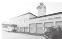
移転後の消防庁舎の暖房は
