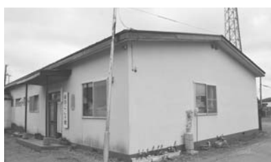
老朽化が進む施設
