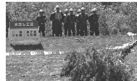
弟子屈及び川湯水防団による木流し工法の訓練
