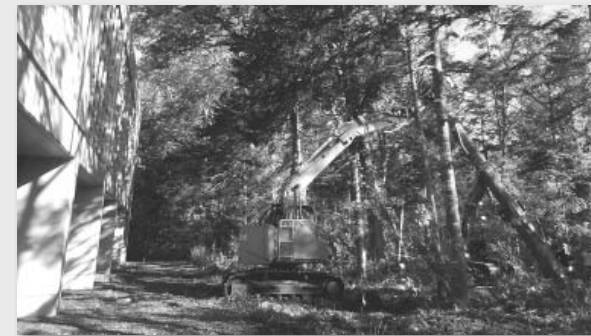
川湯小学校での伐採作業
