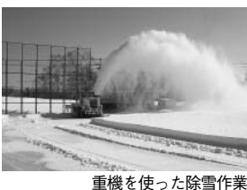
重機を使った除雪作業
