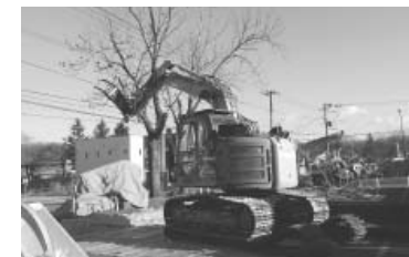
重機を使って作業を実施
