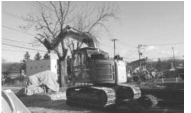
重機を使って作業を実施
