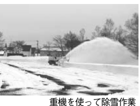
重機を使って除雪作業
