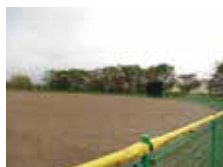
改修された球場
