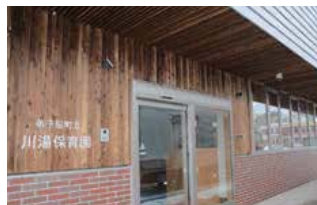
新園舎の外装
