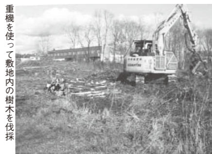
重機を使って敷地内の樹木を伐採
