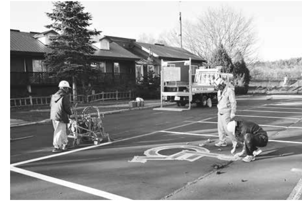
水郷公園駐車場のライン引きを行う多田塗装工業の皆さん
