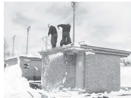
屋根の防水改修工事を行う北海化学防水の皆さん
