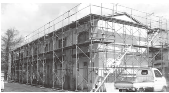
改修中の鉛別公住
