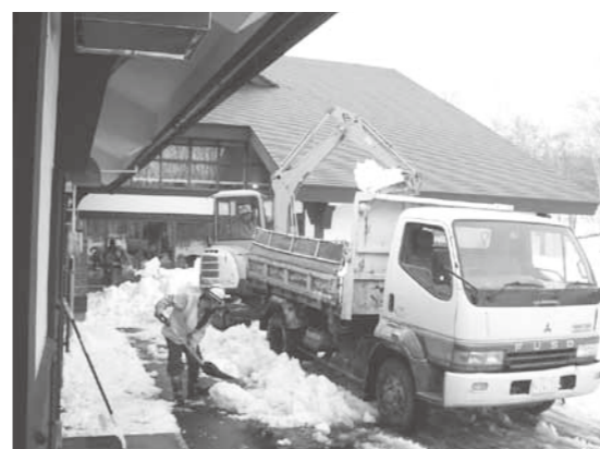
除雪作業を行う東星渡部建設の皆さん
