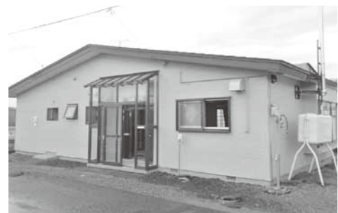
本格移住への足がかりとして(移住者専用住宅)
