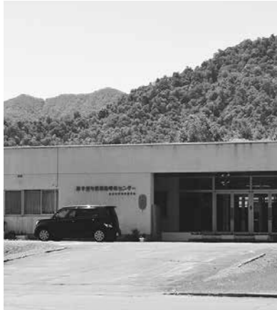
毎年、定期検査が行われる屈斜路研修センター
