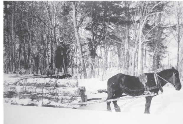
丸太の下にバチバチが付けられている
