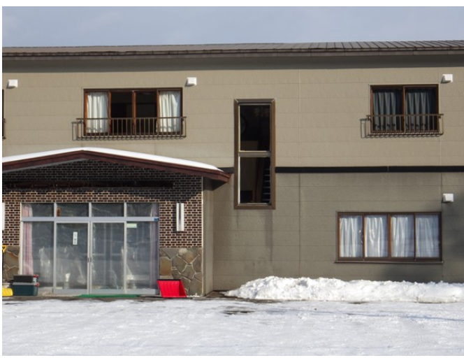
31. 池田屋付近 ホテル開絊 低圧受電施設
