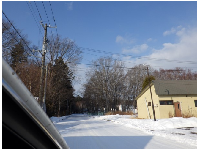
14. 川湯の森病院付近 川湯の森病院側へ既存 高圧架空線が分岐
