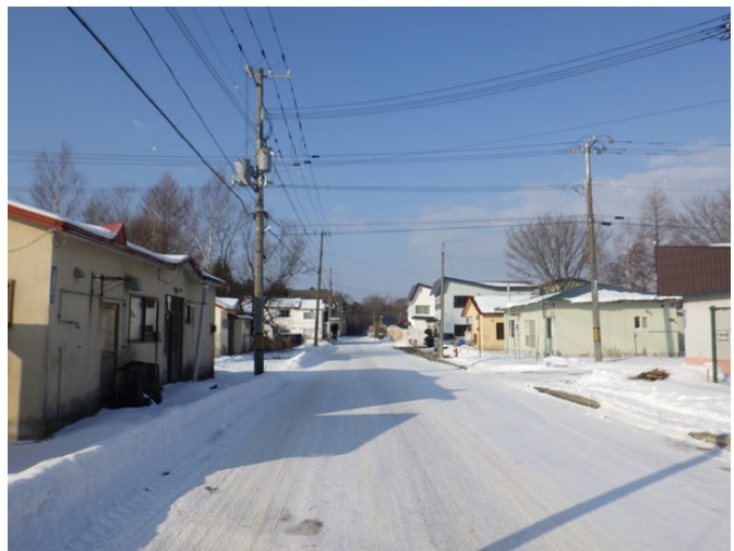
13. 農村センター付近 上記12. の撮影地点から 反対側を撮影 高圧自営線と既存高圧 架空線の交差あり
