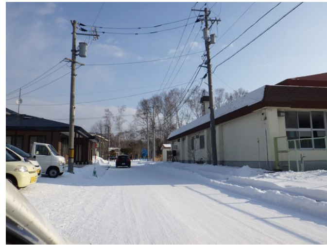
16. 川湯の森病院付近 川湯保育園 低圧受電施設 高圧自営線は川湯保 育園裏の道路を横断して 川湯の森病院側へ 既存高圧架空線との交 差あり
