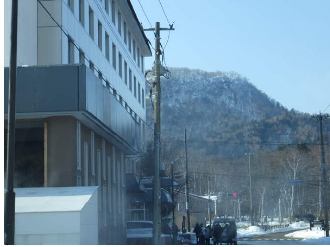
24. 欣喜湯付近 高圧受電施設 受電中と施設側気中開閉器もあわせて撮影
