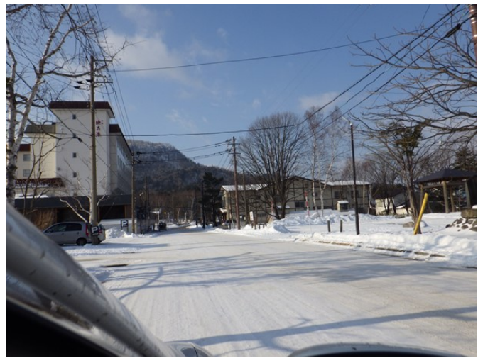
23. 川湯温水プール付近 川湯温水プール前からふるさと館方向を撮影 写真左が欣喜湯 川湯消防署の西側横に川湯温水プールあり 低圧受電施設
