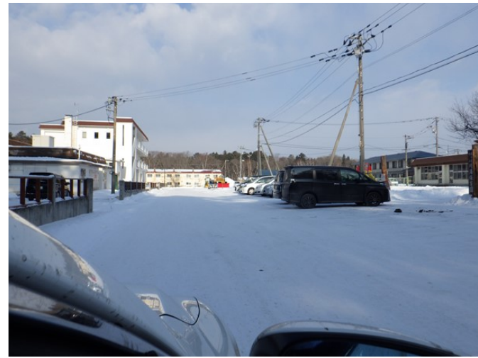
15. 川湯の森病院付近 川湯の森病院進入道路 付近交差点より北方向 を撮影 川湯の森病院(旧建物) 側に高圧自営線を敷設 するスペースなし 写真右側の川湯保育園 敷地内に高圧自営線を 設置することを想定
