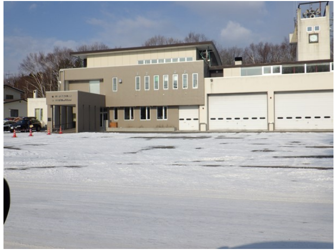
22. 川湯消防署付近 川湯消防署 低圧受電施設
