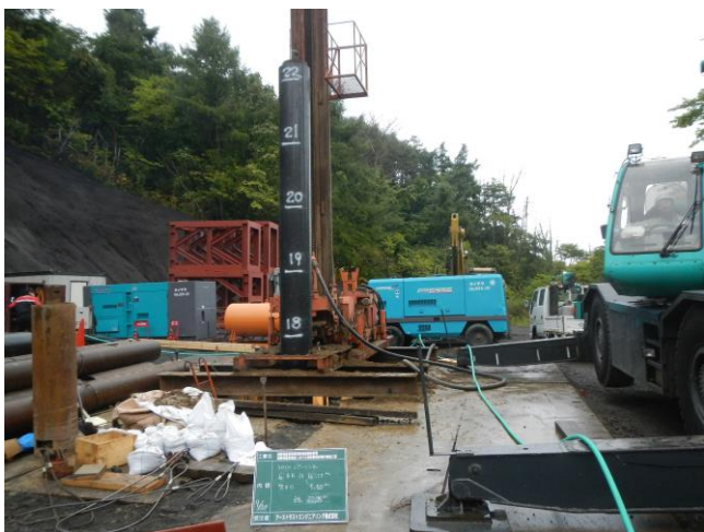
水井戸掘削に使用する機械(エアハンマー)
