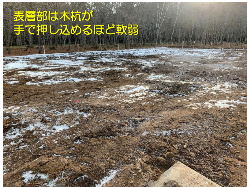
写真① 掘削調査位置状況（2020. 12.10現在）
