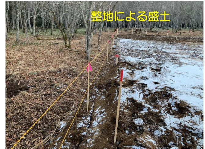
写真 整地による盛土
